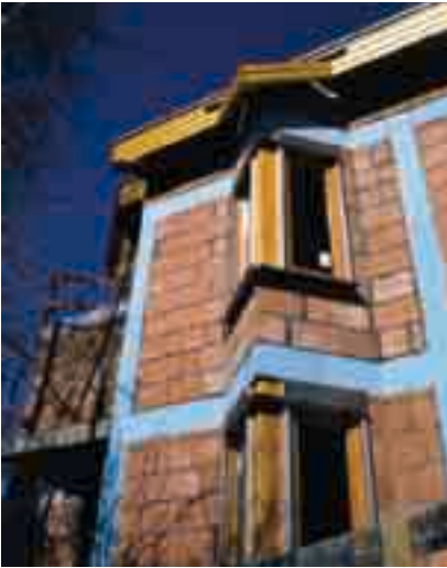
Meglévő hőszigetetlen ablak áthidaló
