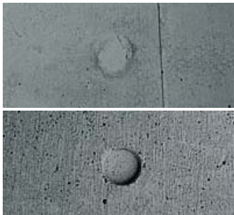
ankerlukak kialakítása
