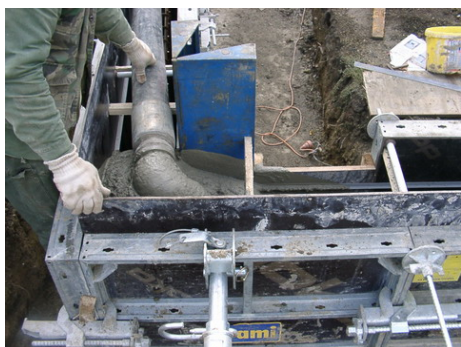
öntömörödő beton bedolgozása
