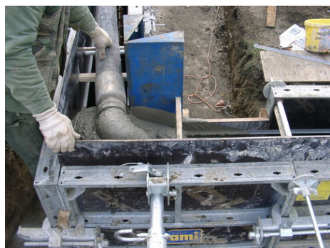
öntömörödő beton bedolgozása
