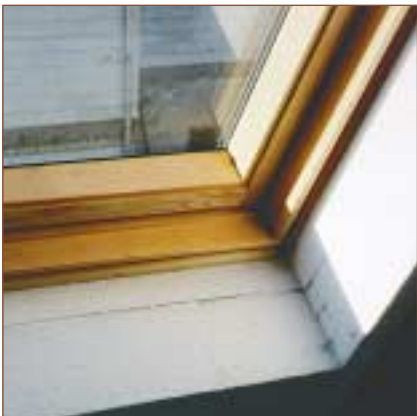
Síkban fekvő tetőtér ablak környezetének hőszigetelése.
