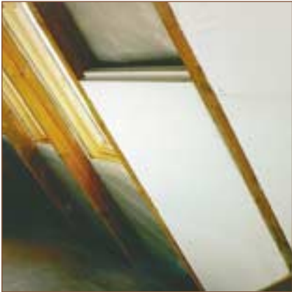
Az elem jól illeszthető a vápa gerendához.
