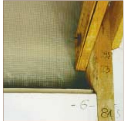
A fogópárok melletti hőszigetelés kialakítása
