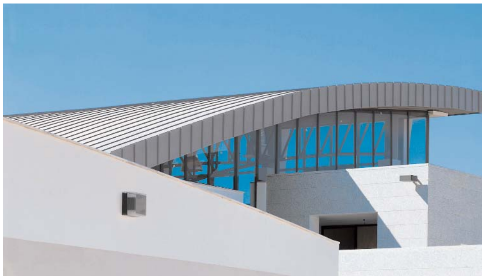
RHEINZINK®-lemezből kialakított oromszegély derékszögű állókorcos fedéssel burkolt – széles – oromszegély – fedéssel
